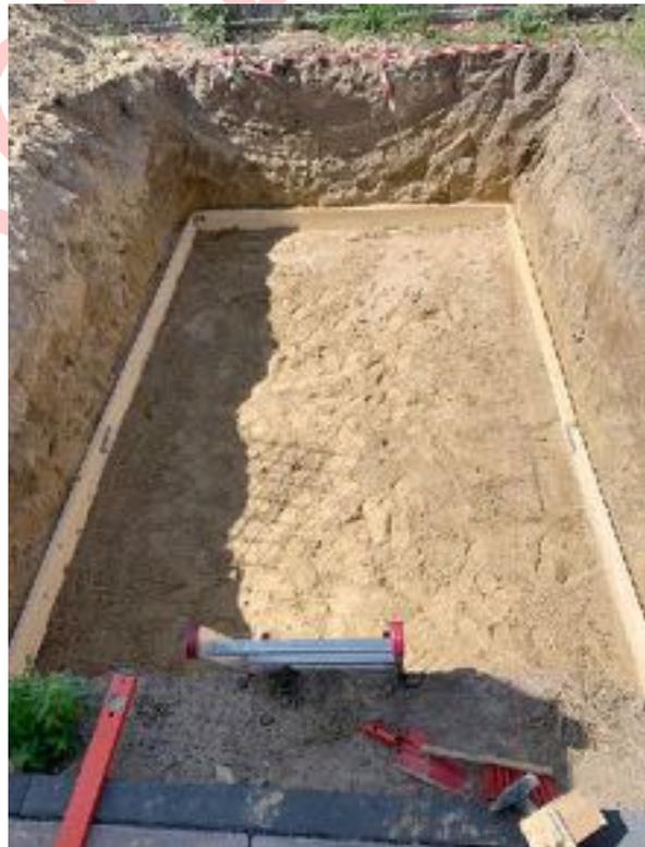
**WICHTIG:** Stellen Sie sicher, dass aufgrund der Bodenbeschaffenheit ein versickern von Wasser wie z.B. bei Starkregen, Überflutung, hoher Grundwasserstand usw... möglich ist. Evtl. ist eine Drainage notwendig um ein aufschwimmen des Pools zu vermeiden. Dies ist durch eine fachliche Bewertung des Erdbodens sicher zu stellen. Das Becken kann durch das aufschwimmen stark beschädigt oder zerstört werden. Das Becken nie unbefüllt stehen lassen um ein aufschwimmen zu vermeiden.
