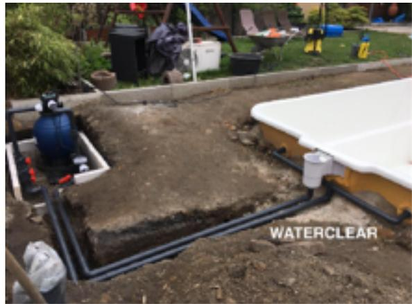
Der Schacht sollte sich, wenn möglich, direkt am Becken befinden. So werden unnötig lange Verrohrungen vermieden und somit die Gefahr von Undichtigkeiten verringert.
