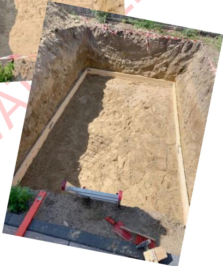
2. Anfertigen der Bodenplatte. Mind. 10cm mit Eisenmatten verstärkt.
